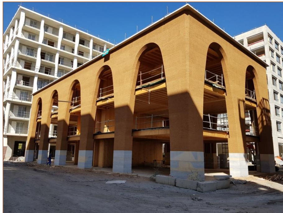
L'Orangerie, Confluence, Lyon Clément Vergely (architectes); Nicolas Meunier Le pisé (Maçon-e-s) Batiserf (BET structure) ©
